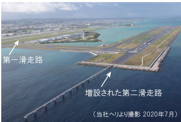
写真1 那覇空港滑走路増設事業の現況
