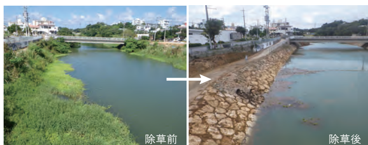
写真4 抽水植物帯の除去の様子(左:除草前、右:除草後)
