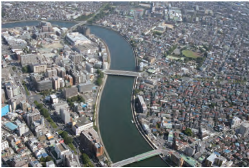
写真1 鶴見川下流域(写真提供:京浜河川事務所)
