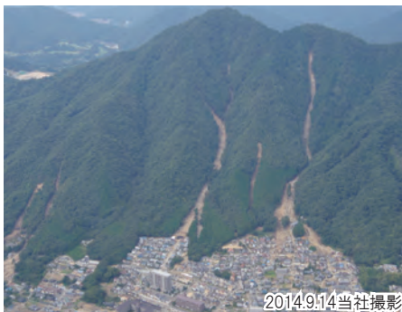
写真1 山麓斜面に近接する宅地と土砂災害(広島市八木西地区)
