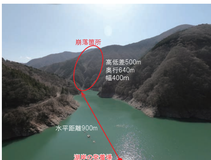
写真2 崩落箇所の状況
