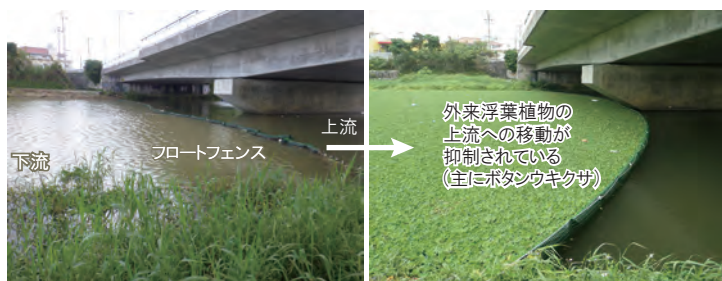
写真3 設置したフロートフェンス
