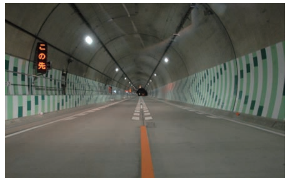
写真1 トンネル壁面デザインによる交通安全対策 (阪神高速8号京都線 稲荷山トンネル)
