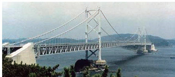
写真3 大鳴門橋(兵庫-徳島間の鳴門海峡両端を結ぶ)
