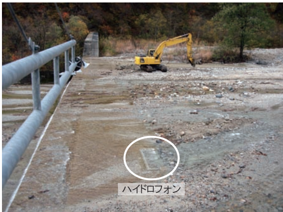
写真2 ハイドロフォンの設置例
