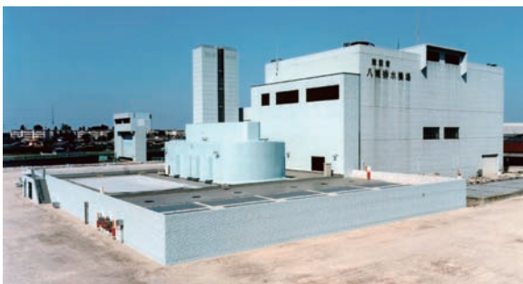
写真7 八潮排水機場(埼玉県八潮市)
