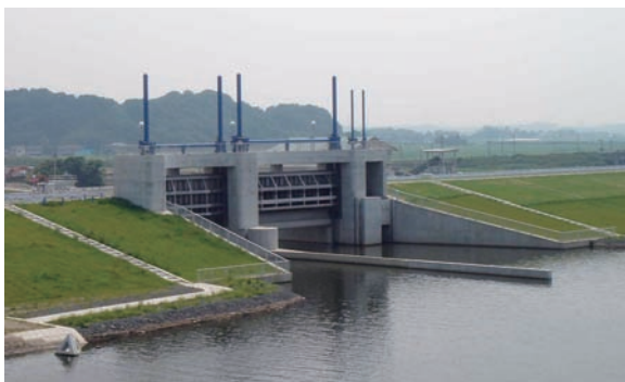
写真1 利根川両総水門(千葉県香取市利根川)
