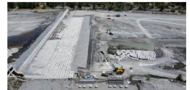
農業用取水堰の護岸・護床工復旧工事の様子
