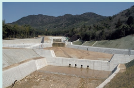
土石流堆積工(山口県上田南川)
