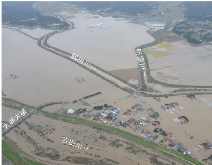
令和元年東日本台風による浸水の様子
