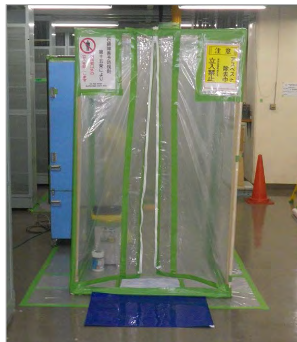
アスベスト撤去工事
