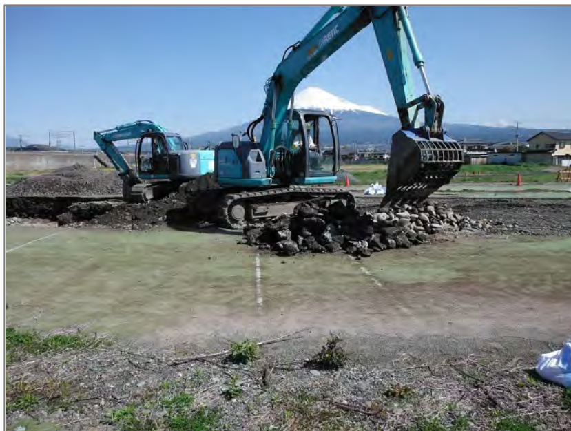
土壤汚染対策工事
