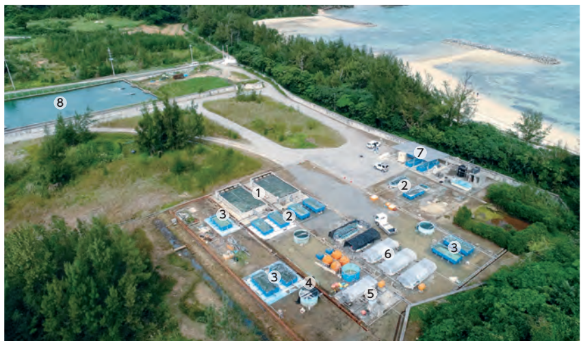
亜熱帯環境研究所 2011年6月稼働開始 敷地面積：17,558m 2 1.大型コンクリート水槽(海草移植試験) 2.海草生育試験 3.海草種苗ストック 4.海藻類培養試験 5.泡沫式分離装置(飼育海水浄化) 6.シラヒゲウニ育成 7.サンゴ種苗・ヒメシヤコガイ育成 8.海草生育環境池
