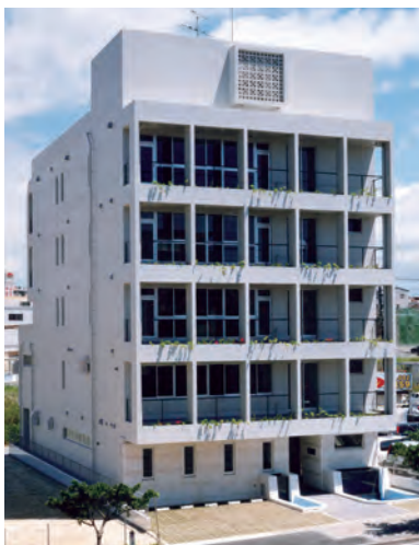
沖縄支社 2002年5月竣工 生物飼育実験室、生物検鏡・分析室、化学分析室、機器分析室、調査機材倉庫、研修室 併設
