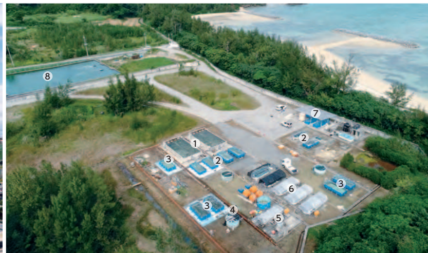
亜熱帯環境研究所 2011年6月稼働開始 敷地面積：17,558m 2 1.大型コンクリート水槽(海草移植試験) 2.海草生育試験 3.海草種苗ストック 4.海藻類培養試験 5.泡沫式分離装置(飼育海水浄化) 6.シラヒゲウニ育成 7.サンゴ種苗・ヒメシャコガイ育成 8.海草生育環境池
