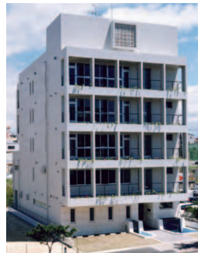
沖縄支社 2002年5月竣工 生物飼育実験室、生物検鏡・分析室、化学分析室、機器分析室、調査機材倉庫、研修室 併設
